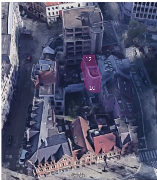
Gevallen waarin de hoogte van de bijgebouwen niet is gerespecteerd
