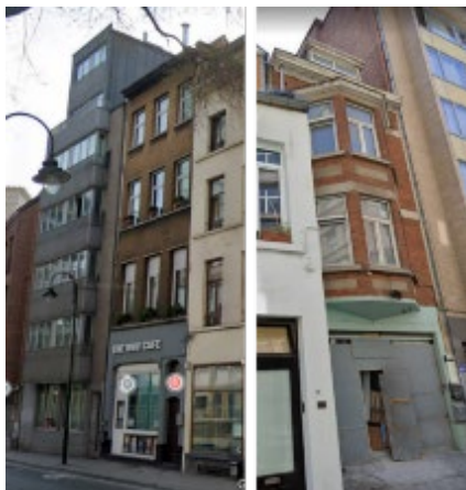
Niet-naleving van de materiaalvoorschriften, Lakensestraat (links) en Zaterdagplein nr. 18 (rechts)
